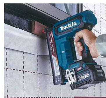
外装下地 / 軒天仮留め
